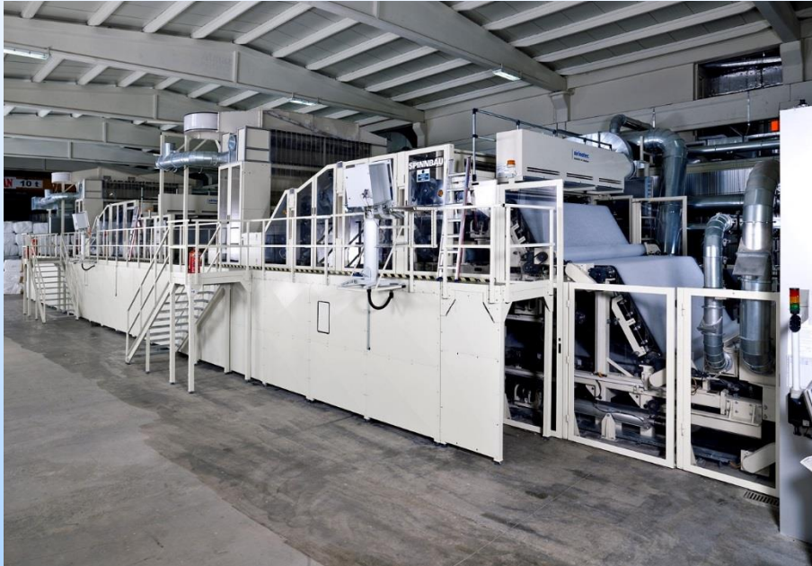
„Direktanlage“ vor Wasserstrahlverfestigung
